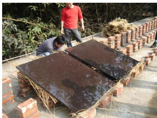
太陽光発電パネルの設置。屋根に設置の基礎工事を行い、緩衝材として藁を使用した。
