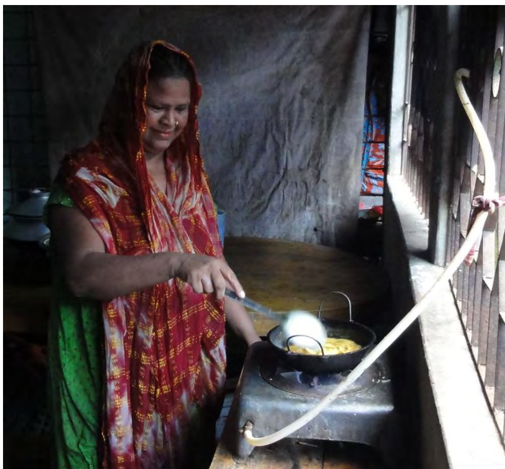
図 1-10: バイオガスのガスコンロ
