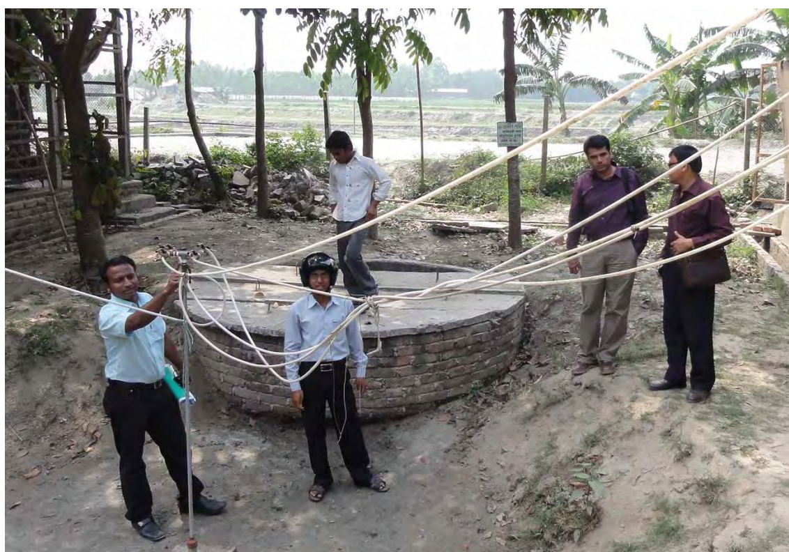
図 1-15: マイクロユーティリティ事業を行っている比較的大きなダイジェスターからのバイオガス供給用チューブ (ダイジェスター自体は地下に設置)
