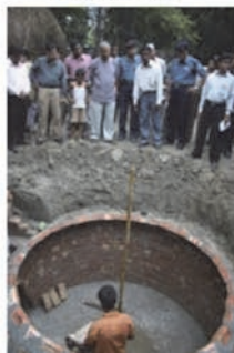
建設中のバイオガス ダイジェスター
