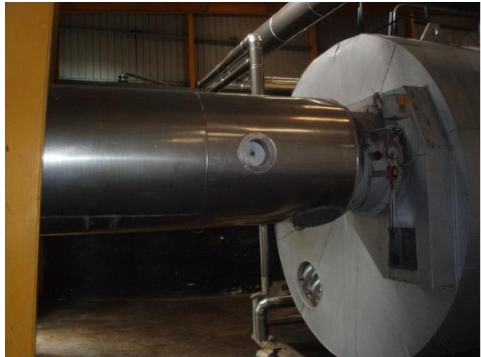
写真 7-2 既存燃料油燃焼ボイラーサンプリング位置（ビール工場内）
